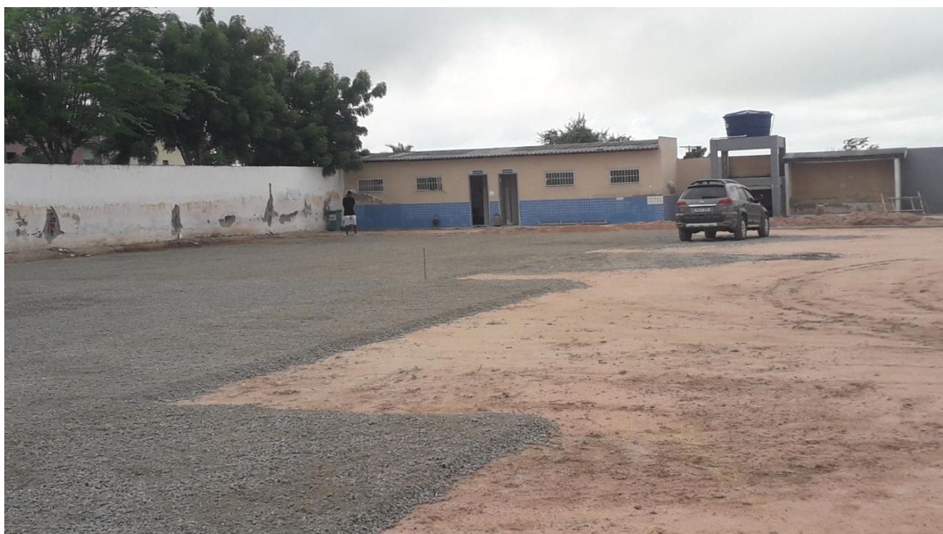
Foto 04 – Vista do campo – Execução de base para instalação do gramado.
