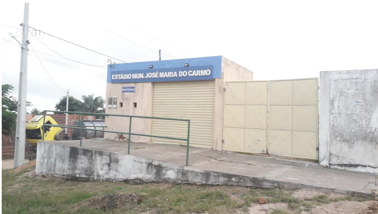
Foto 01 – Vista da atual entrada do Estádio – Sem intervenções.
