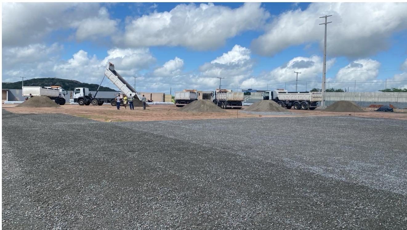
Foto 06 – Vista do campo – instalação dos postes e cruzetas.
