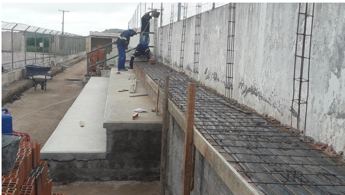
Foto 02 – Vista da arquibancada – montagem de formas e ferragens.
