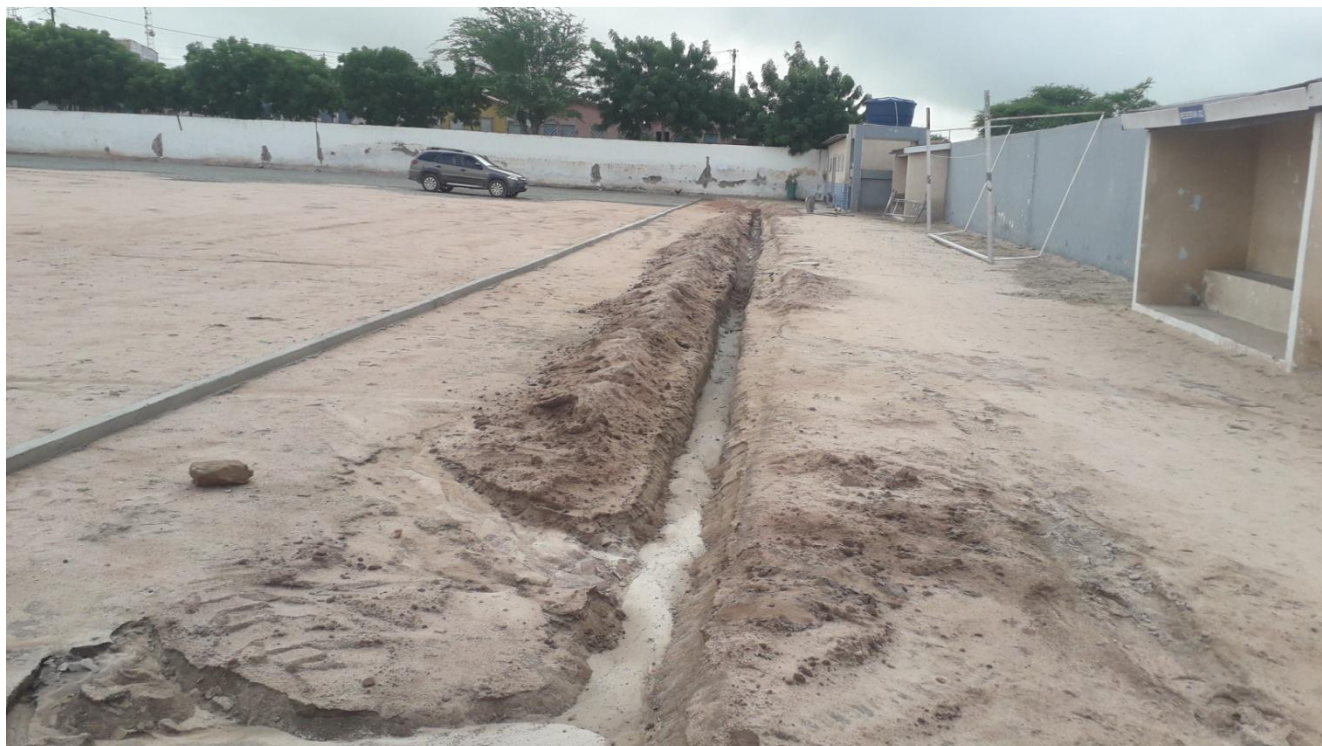
Foto 03 – Vista Internado estádio – Abertura de valas para instalação dos alambrados.
