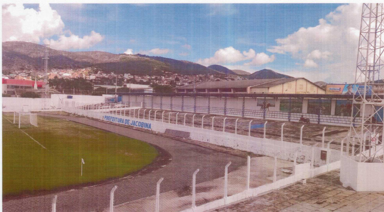
Foto 04 – estrutura metálica e arquibancada.
