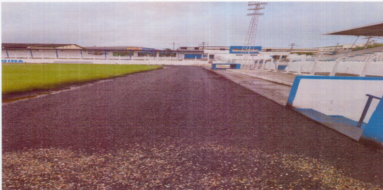
Foto 03 – Vista da pista de atletismo em construção.
