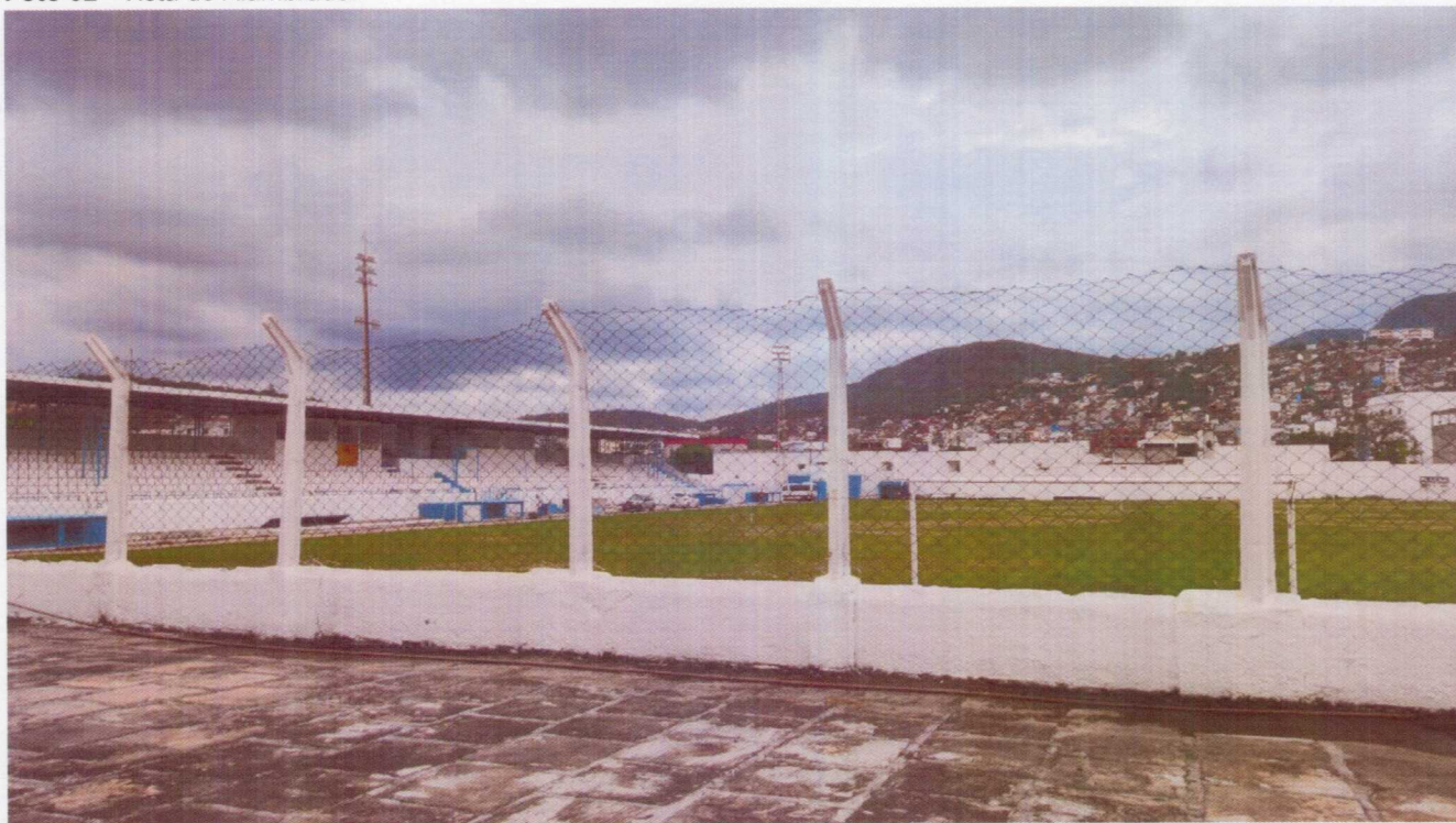
Foto 02 – Vista do Alambrado.
