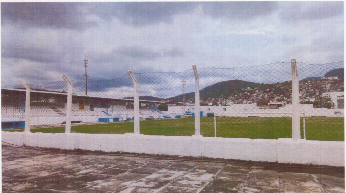
Foto 02 – Vista do Alambrado.
