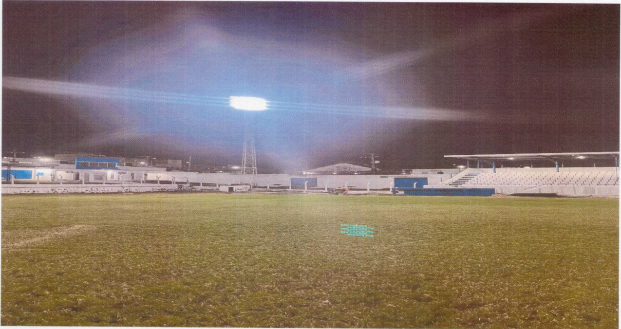
Foto 05 – Poste com refletores.
