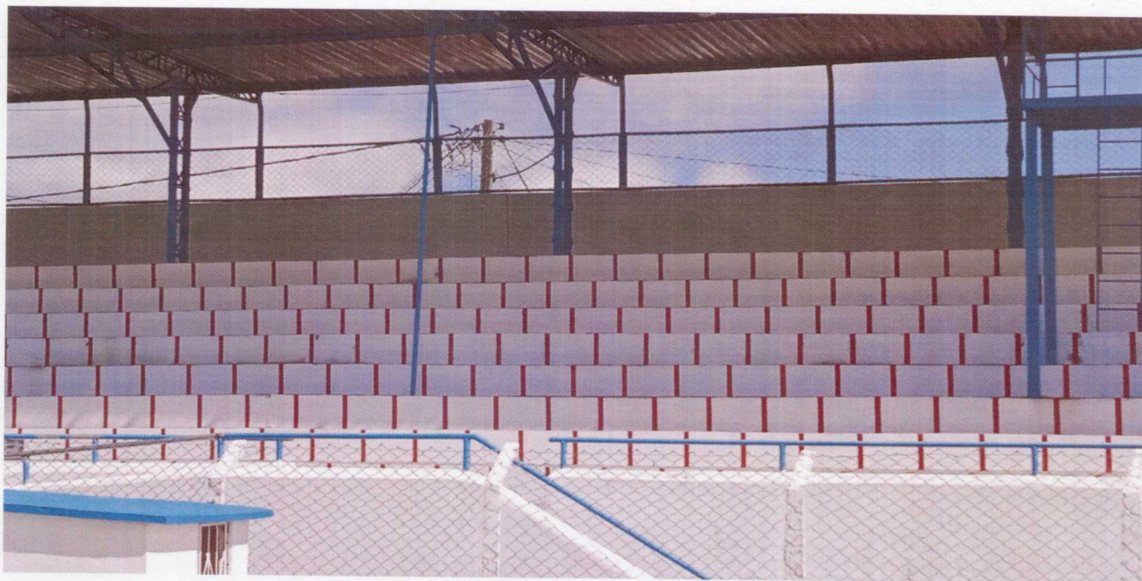
Foto 04 – ESTRUTURA METALICA e Arquibancada.
