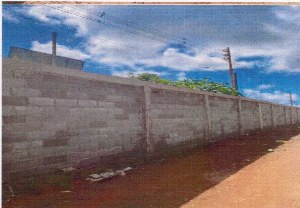
Foto 02 – Construção do muro
