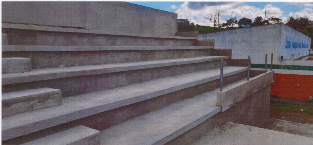
Foto 01 – Vista da arquibancada
