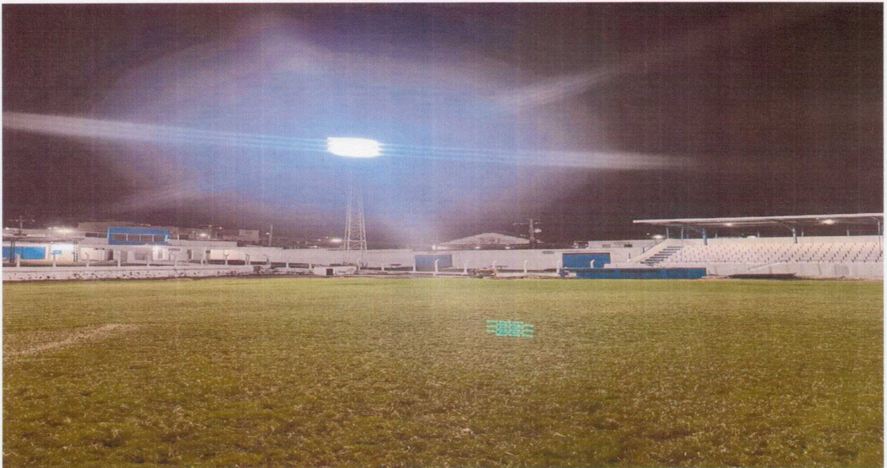
Foto 05 – Poste com refletores.
