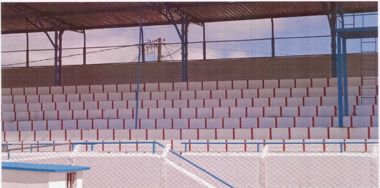
Foto 04 – ESTRUTURA METALICA e Arquibancada.
