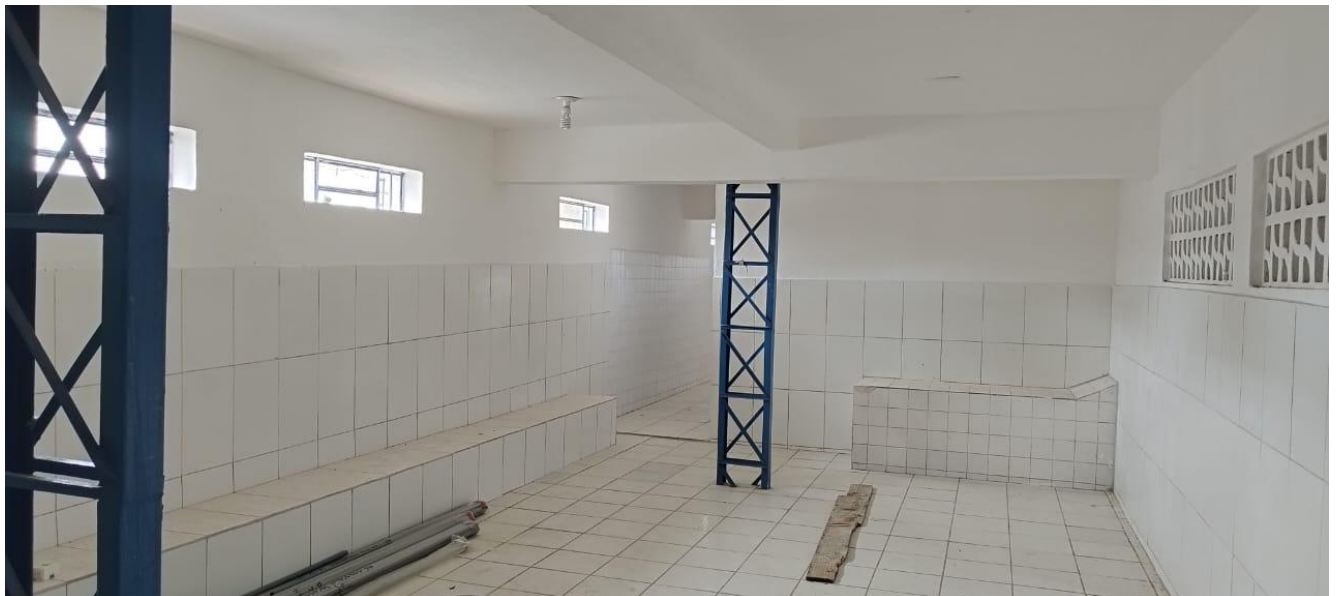
Foto 02 – Vista de um dos Vestiários do estádio.
