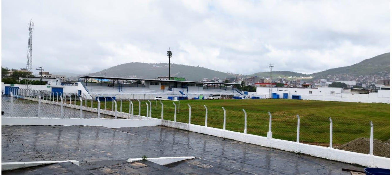
Foto 01 – Vista da Pintura geral do estádio.
