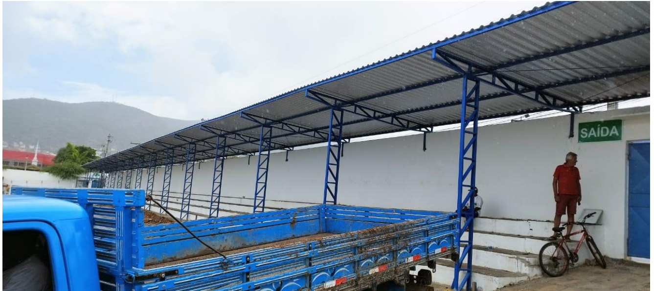
Foto 03 – Vista da cobertura da arquibancada do time visitante.
