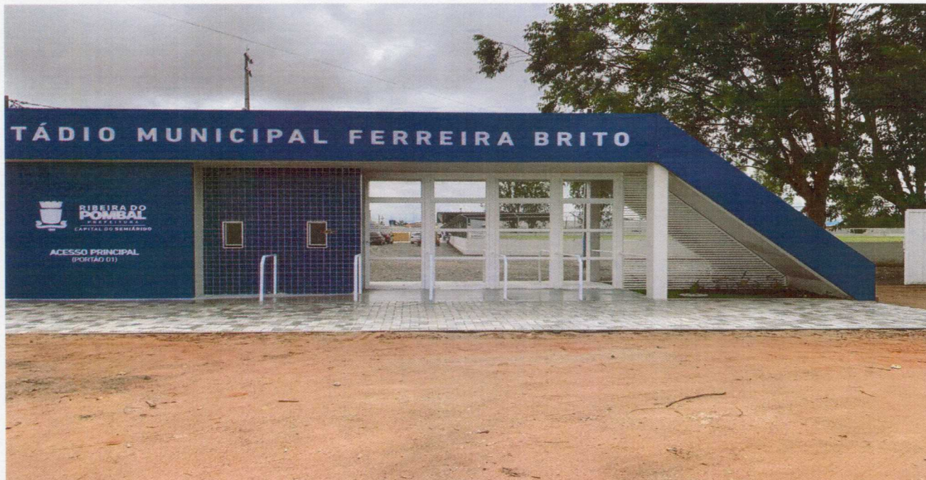
Foto 03 – Vista do pórtico de entrada e bilheteria.
