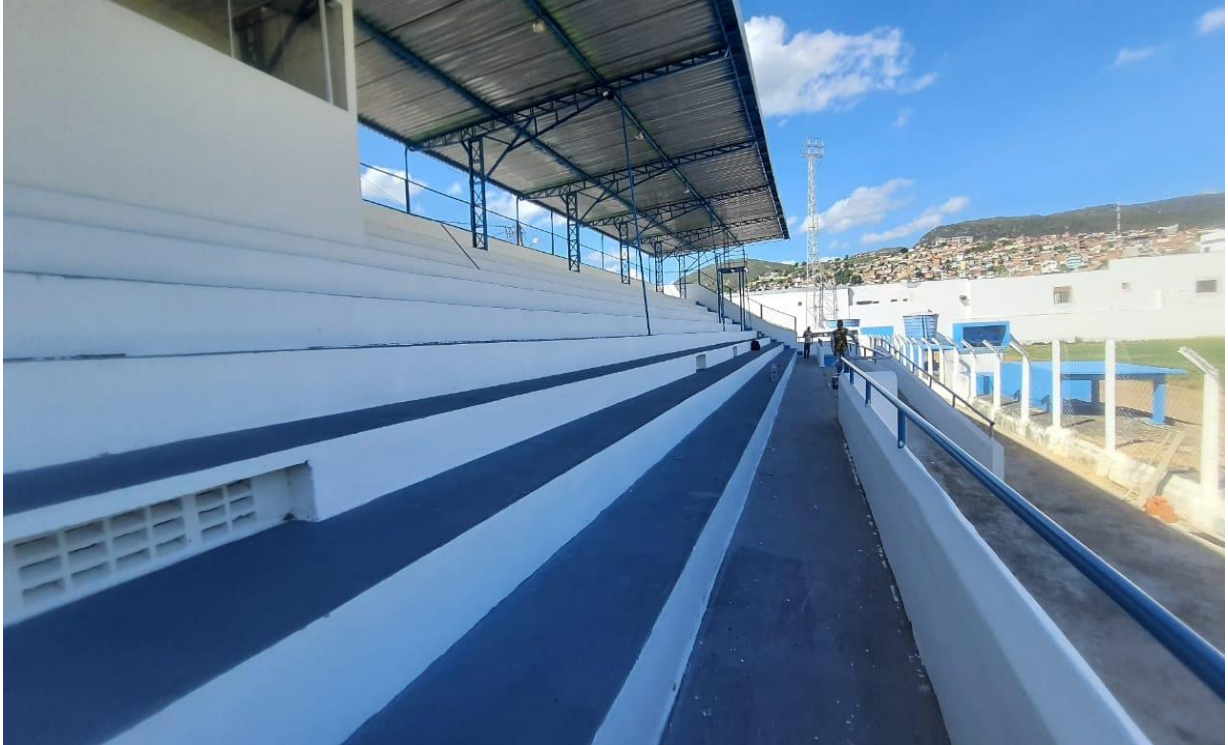
Foto 01 – Vista da ARQUIBANCADA.
