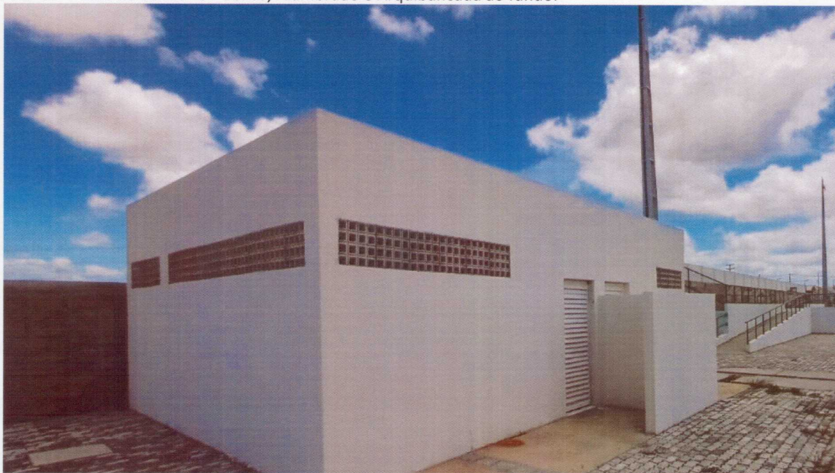
Foto 06 – Vista do Sanitário Público, Alambrado e Arquibancada ao fundo.
