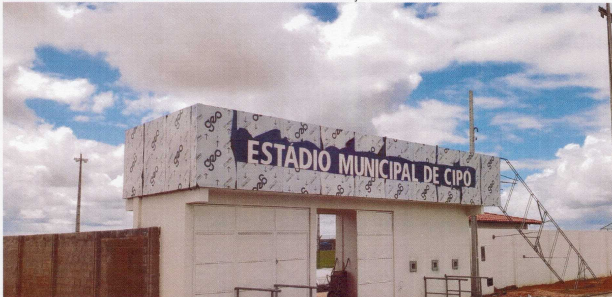
Foto 01 – Vista da Entrada do Estádio com o Pórtico em Construção.
