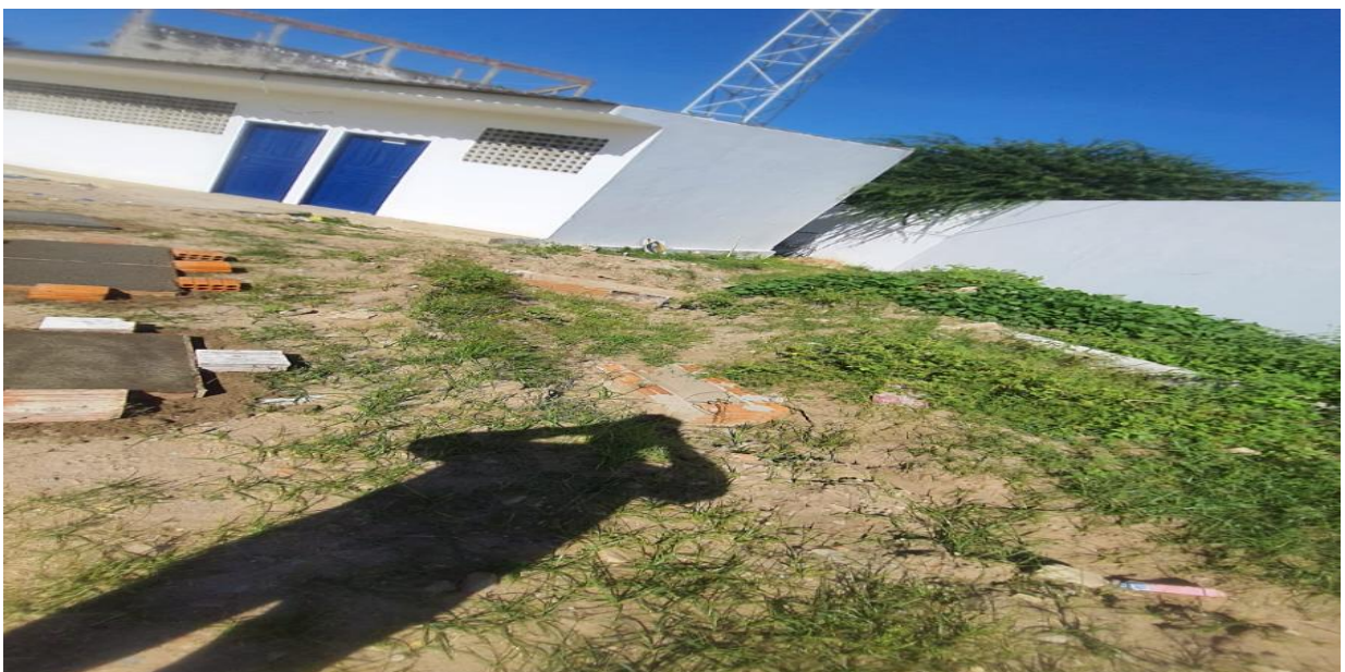
Foto 02 –Vista de um dos Vestiários do estádio.
