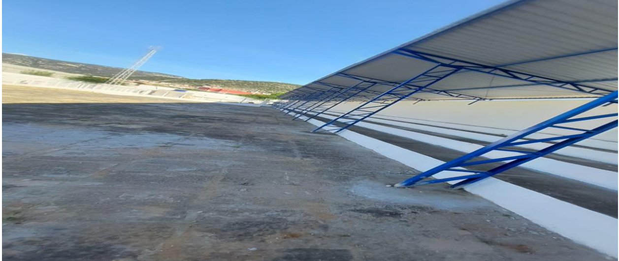
Foto 03 – Vista da cobertura da arquibancada do time visitante.
