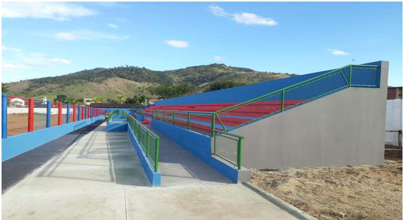
Foto 02 – Execução do Acesso e Alambrado.
