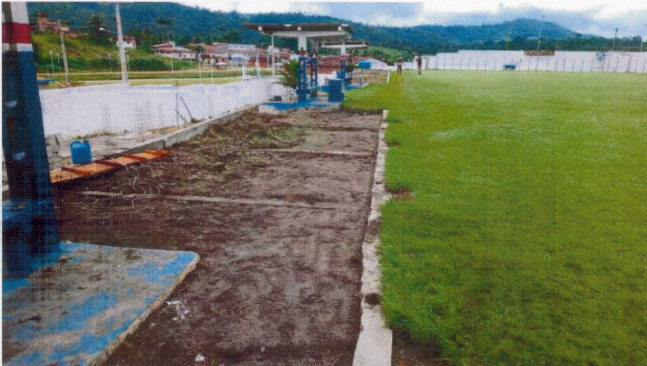
FOTO 01- VISTA DA CONTENÇÃO QUE ESTÁ EM FASE FINAL
