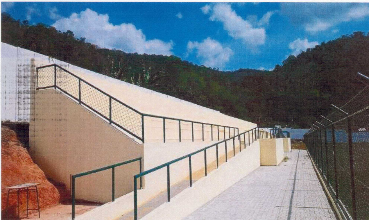
Foto 02 –VISTA DA ARQUIBANCADA
