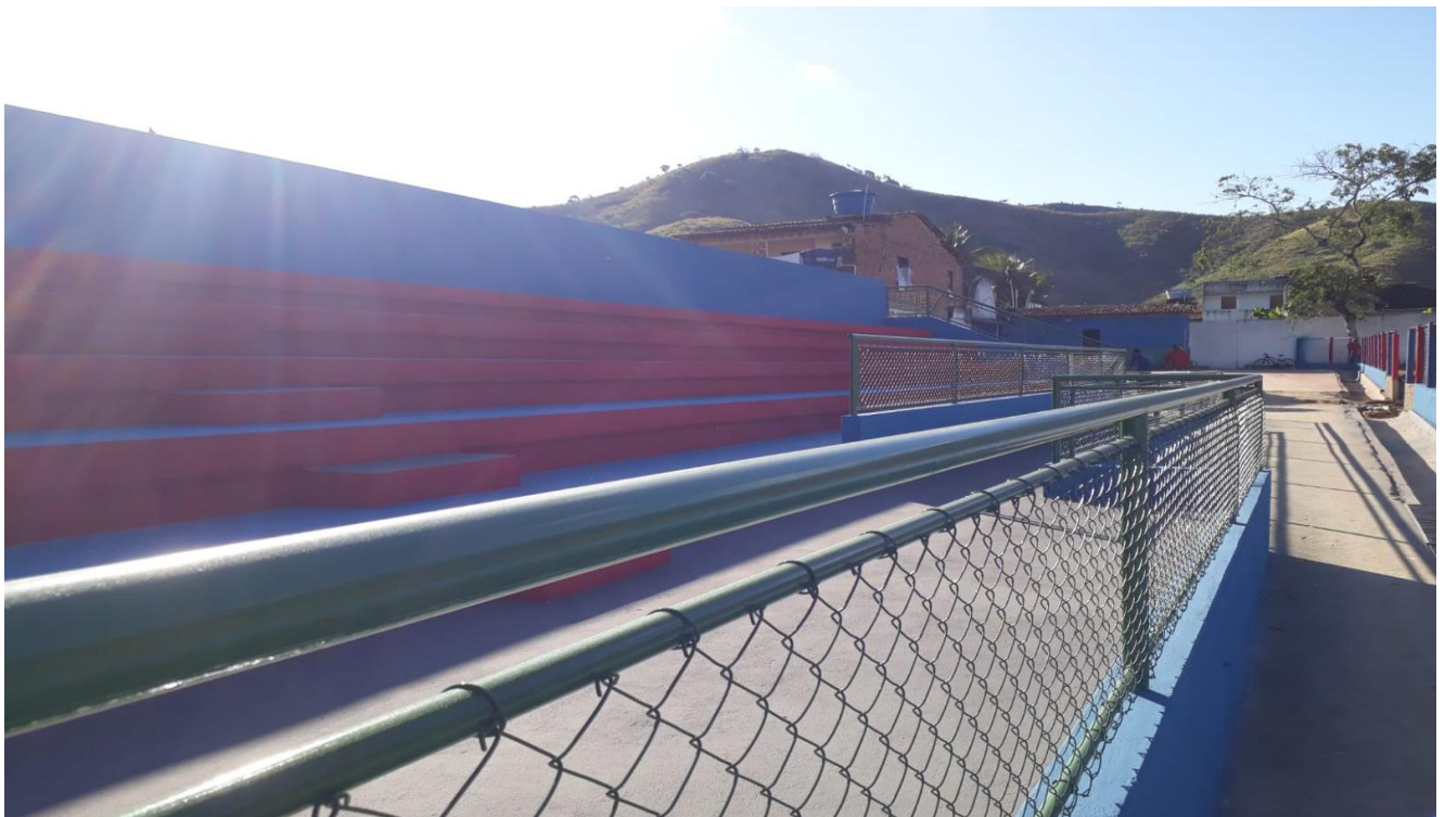
Foto 02 – Execução de acesso e alambrado.
