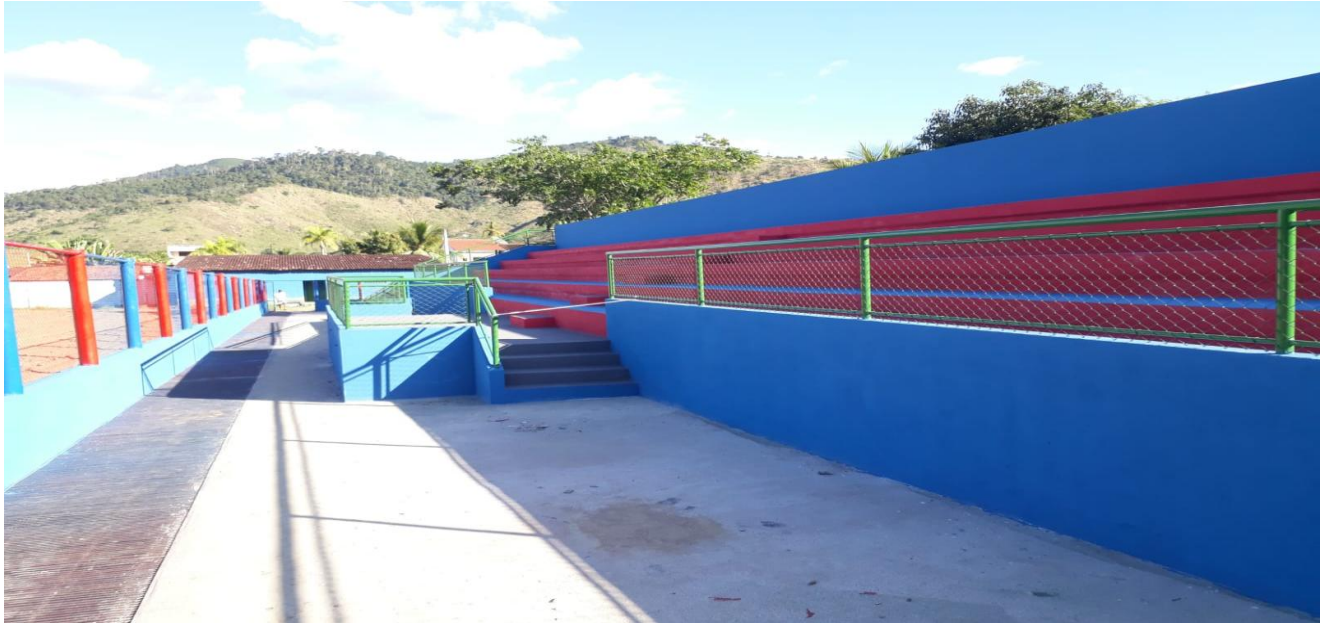
Foto 01 – Execução de arquibancada.
