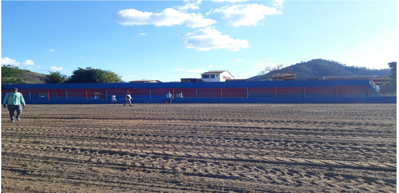
Foto 03 – Execução do plantio da grama.
