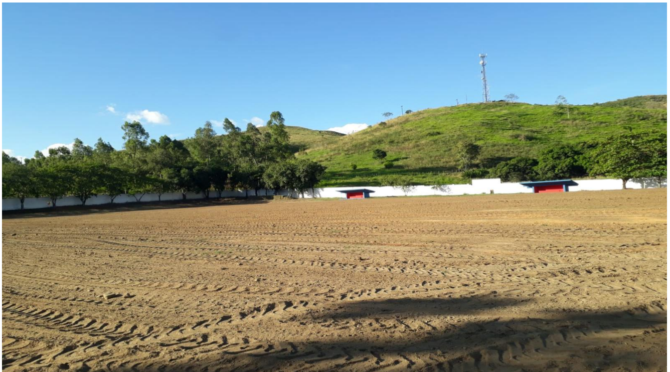
Foto 04 - Execução de banco de reservas.
