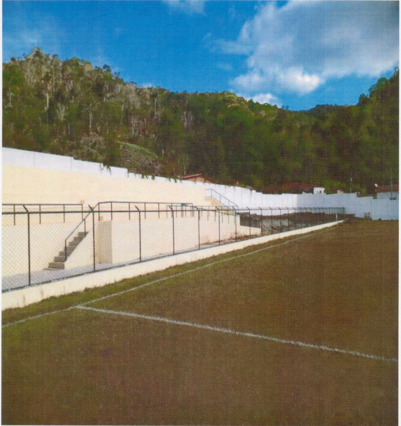
Foto 02 – VISTA DO ALAMBRADO E ARQUIBANCADA
