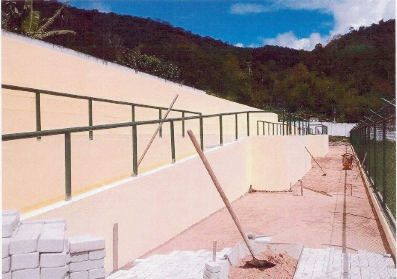
FOTO 01- CONSTRUÇÃO DA ARQUIBANCADA
