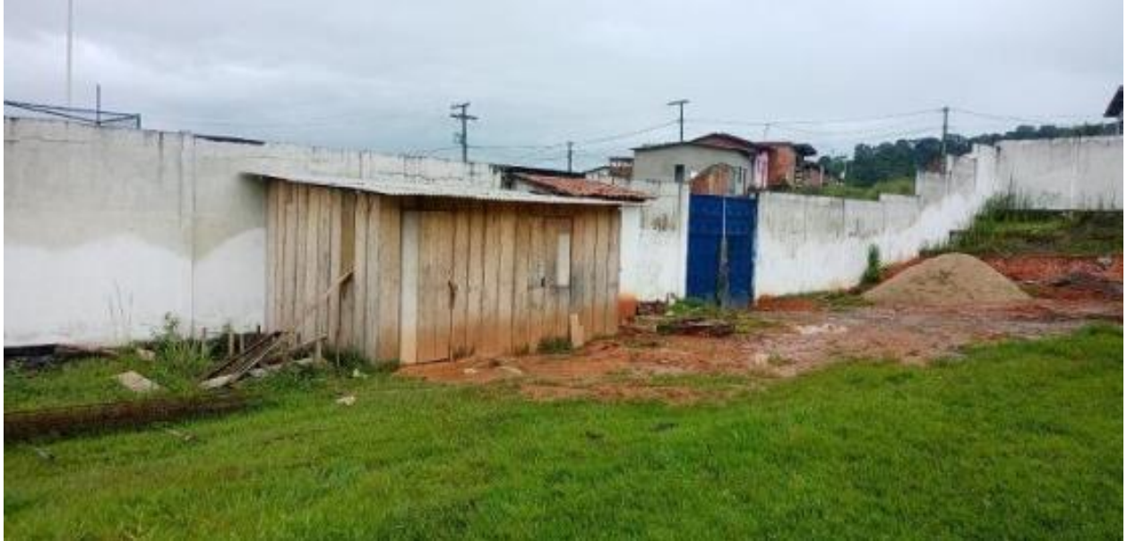
Foto 01 – Limpeza do terreno.
