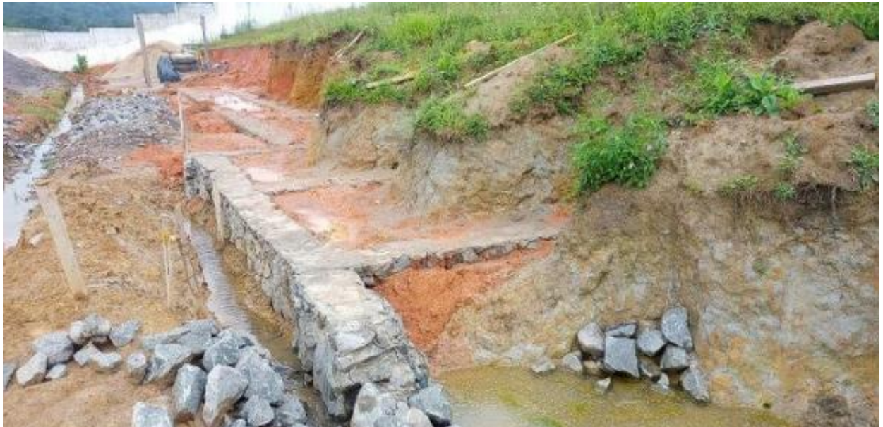
Foto 02 – Embasamento com pedra da arquibancada.
