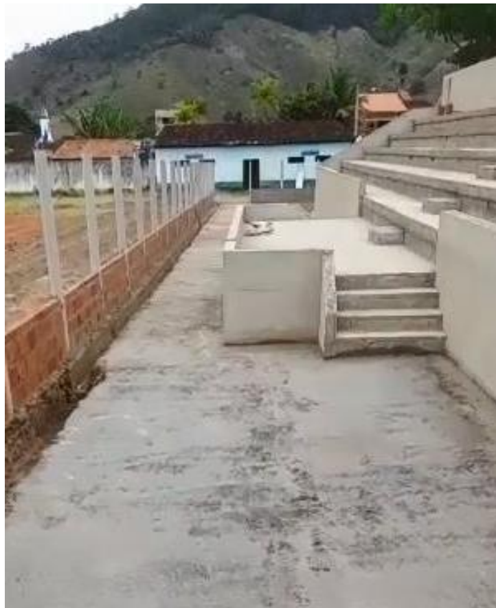
Foto 02 – Execução da arquibancada com quatro degraus.
