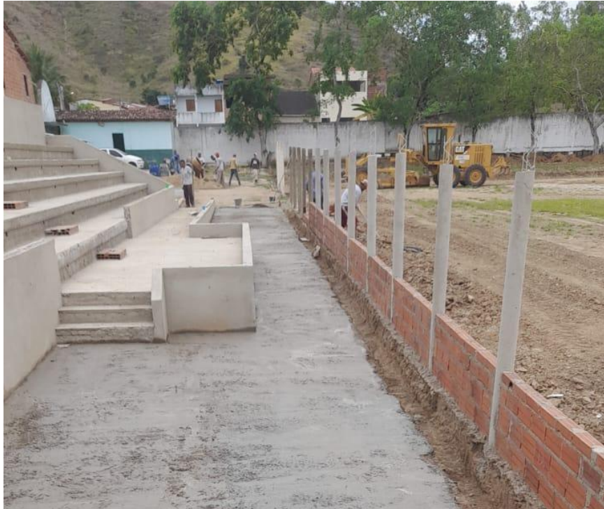
Foto 03 – Execução da arquibancada com três degraus.
