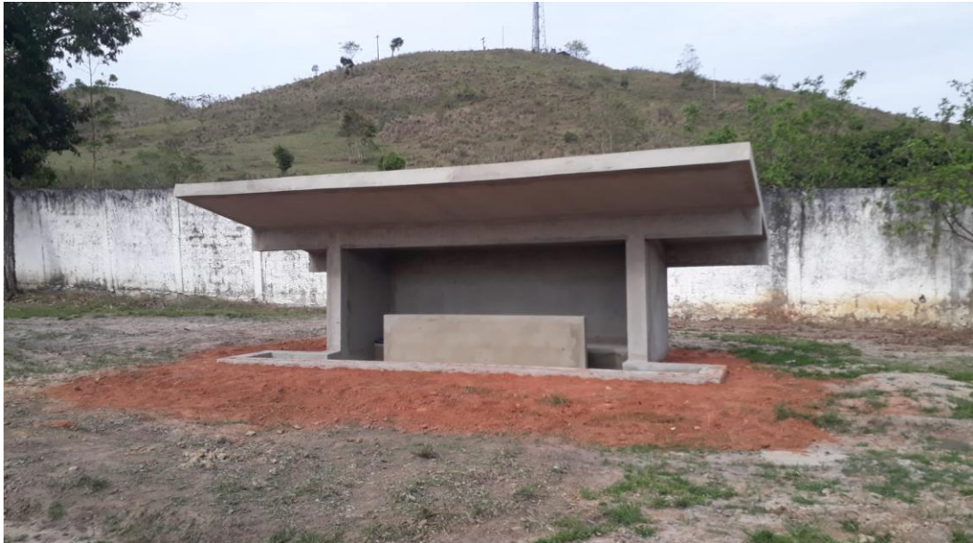
Foto 01 – Construção do banco de reservas.
