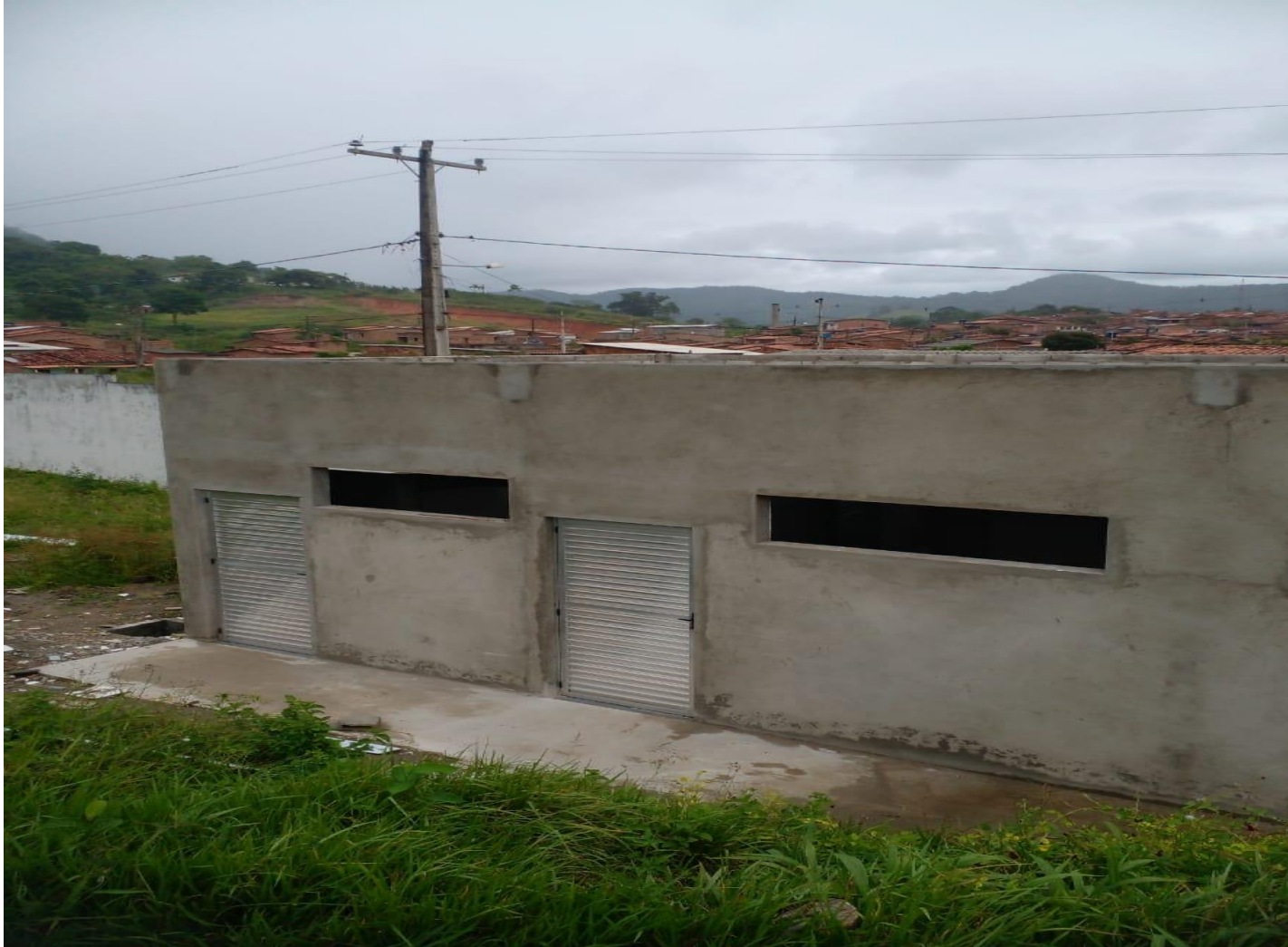
Foto 02 – Construção do vestiário C-4.
