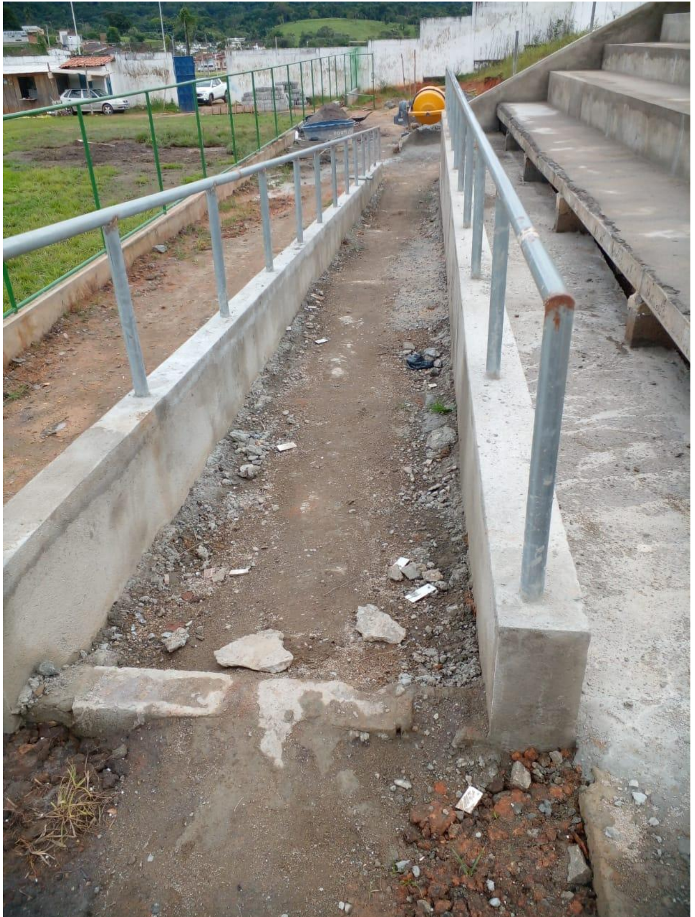
Foto 01 – Construção da arquibancada.
